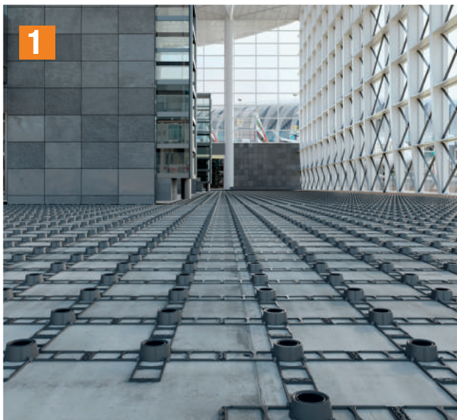
1 Pose de grilles dans la zone destinée à recevoir le plancher surélevé.
