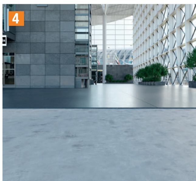
4 Le bétonnage monolithique crée un plancher continu, très résistant aux charges et anti-feu.
