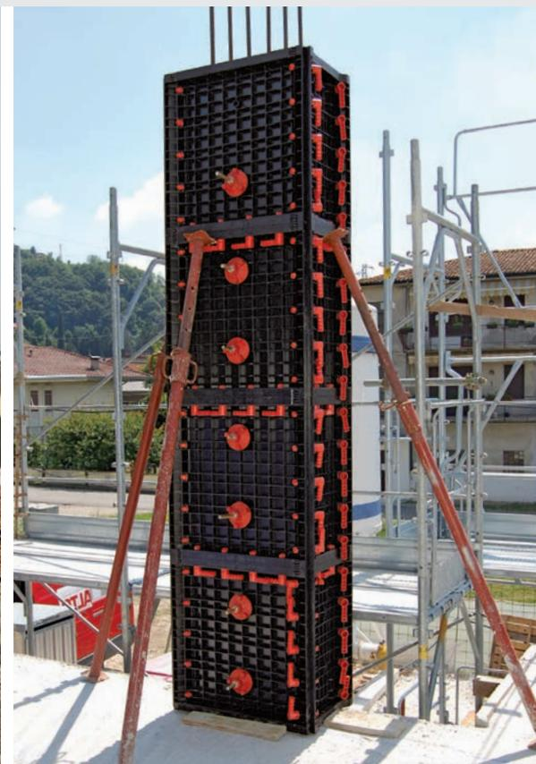
**GEO TUB PANEL EST UN COFFRAGE EN TECHNOLOGIE POLYMER POUR REALISER DES POTEaux CARRÉS ET RECTANGULAIRES.**
